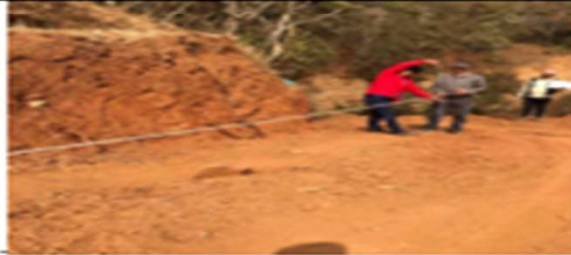
वडा नं ६ नयाँ ट्रक निर्माण
