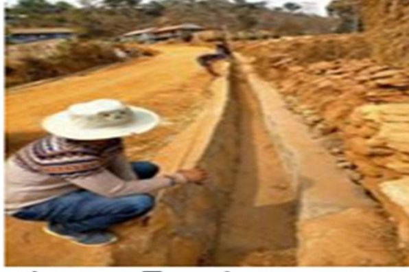
दोबानटार मिलनचोक सडक नाला निर्माण वडा नं ०४
