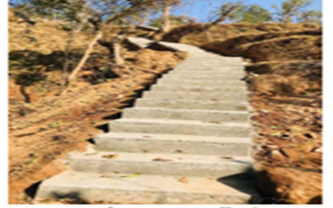
वडा नं ६ Foot trail निर्माण
