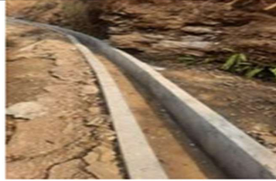
वडा नं २ सिंचाई कुलो निर्माण
