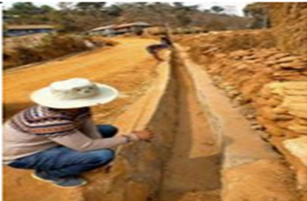
दोबानटार मिलनचोक सडक नाला निर्माण वडा नं ०४
