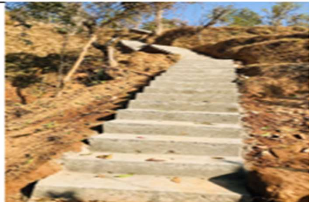
वडा नं ६ Foot trail निर्माण
