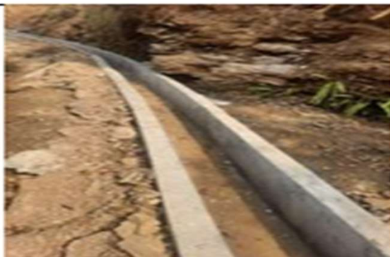
वडा नं २ सिंचाई कुलो निर्माण
