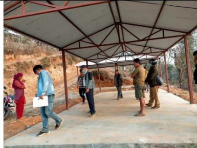
वार्ड नं ०२ ट्रस भवन निर्माण
