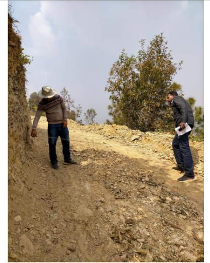
जिलिम खोला सडक निर्माण कार्य वडा नं ०४
