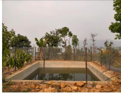
वडा नं २ सिंचाई पोखरि निर्माण
