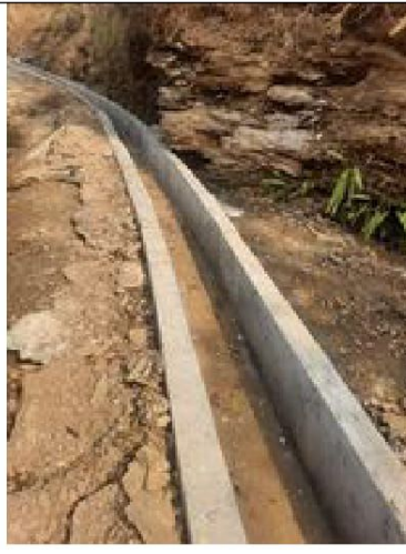
वडा नं २ सिंचाई कुलो निर्माण
