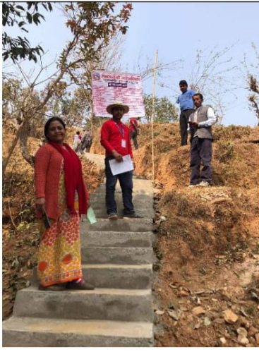
वडा नं ६ Foot trail निर्माण
