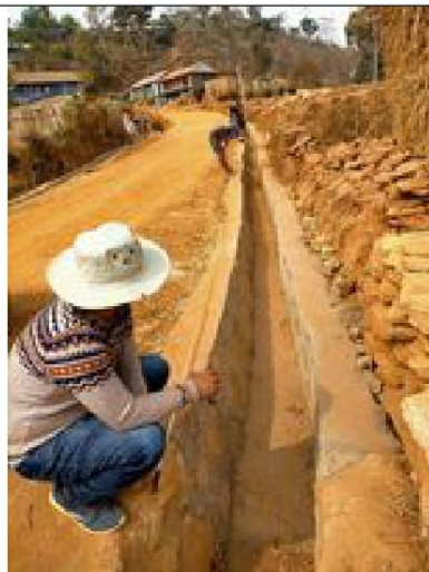
दोबानटार मिलनचोक सडक नाला निर्माण वडा नं ०४
